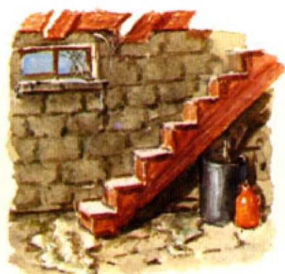
カビの生えた地下室
